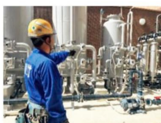
貯水槽設備の点検の様子
